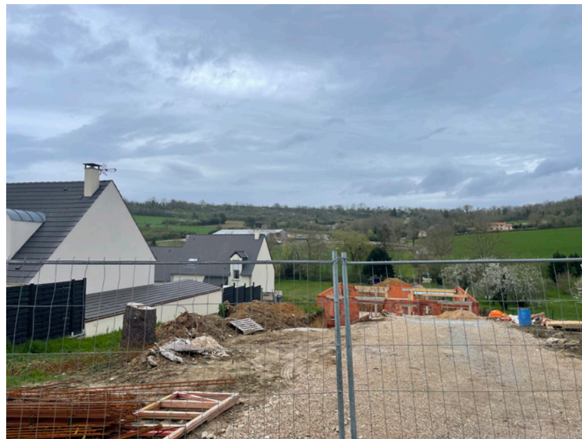
Nouvelle construction à Beynes
